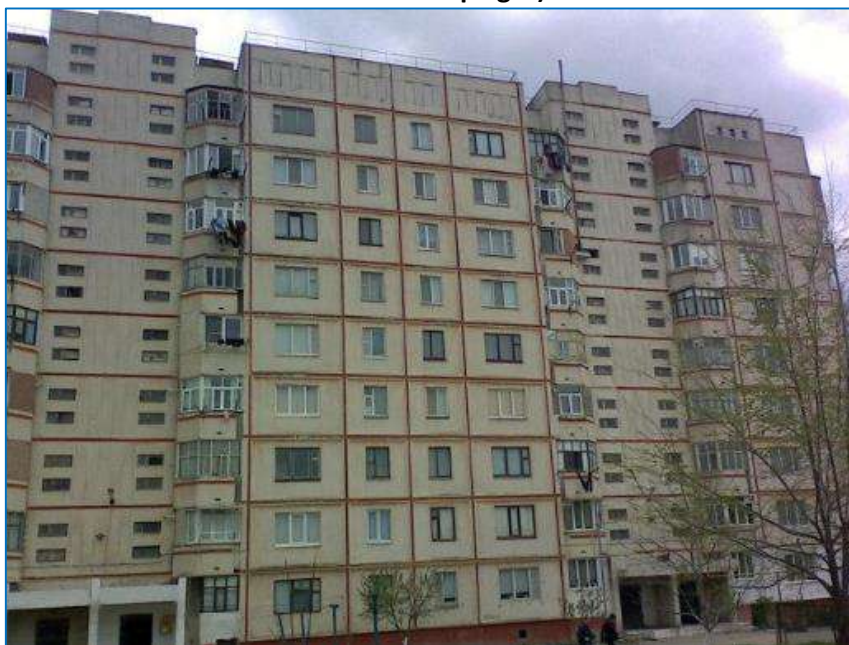
Figura 114: Bloc locativ multietajat din mun. Ungheni (fără izolare termică, doar cu unele coșuri ale centralelor pe gaz)
